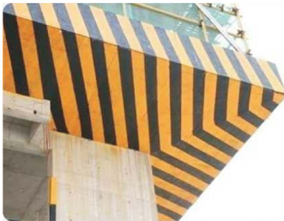
脚手架隔离防护做法
