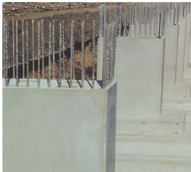
柱筋保护（薄膜包缠）
