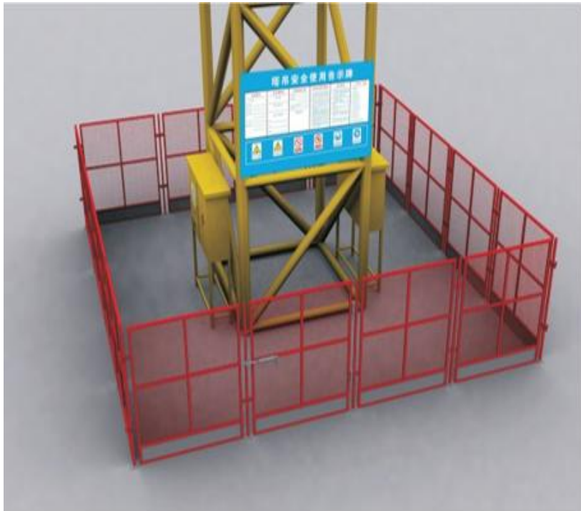
塔吊基础围护
