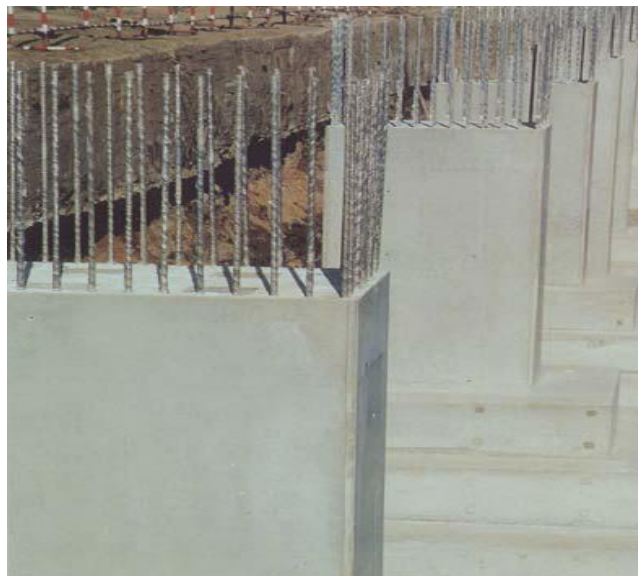
柱筋保护（薄膜包缠）
