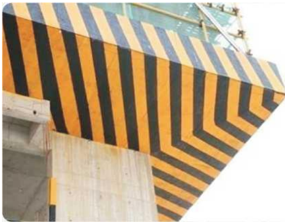
脚手架隔离防护做法
